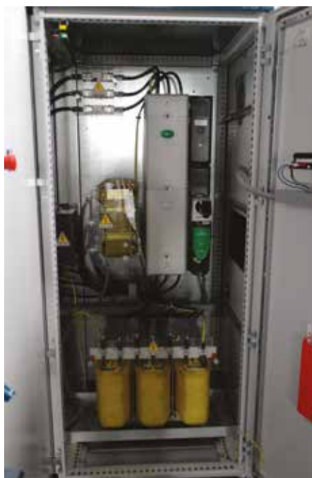
Un dettaglio dell'inverter, cuore del sistema Sincrosupply
